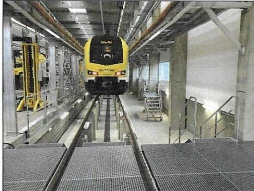
**Abbildung 11** Innenansicht Werkstatt mit aufgeständertem Gleis
